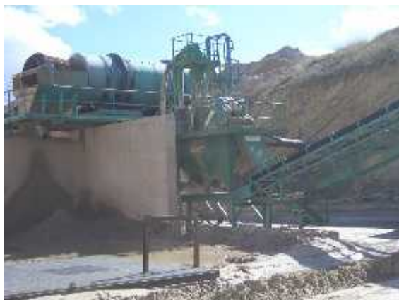
Instalación para lavado de arenas
